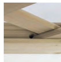
Trou pour l'évacuation de l'eau
