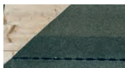
Bande bitumineuse
