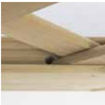
Bohrung für Wasserablauf
