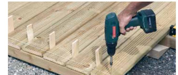
Nach dem Verschrauben schneiden Sie den Überstand rundum sorgfältig bündig ab (Kappschnitt) oder planen bewusst einen Überstand ein. Alternativ haben Sie auch die Möglichkeit, das bündig abgeschnittene Ende mit einer Diele zu verblenden. Anschließend fasen Sie die Schnittkanten mit einem Elektroholbel, einem Bandschleifer oder mit Schleifpapier an.
